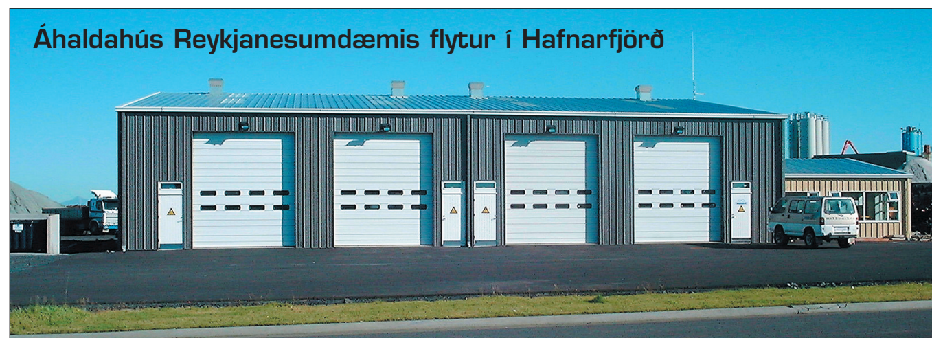
Nýtt áhaldahús rekstrarstjóra Reykjanesumdæmis að Hraunhelli 4 í Hafnarfirði, tvö bil af fjórum.
